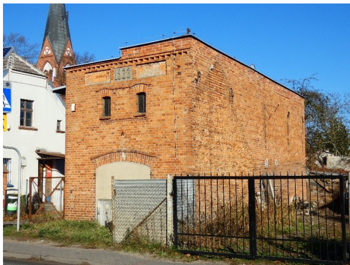
Fot. 11. Budynek gospodarczy przy poczcie w Łochowie
