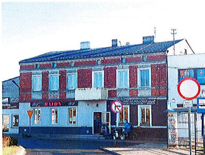
Fot. 10. Dom, ob. budynek mieszkalno-usługowy w Łochowie
