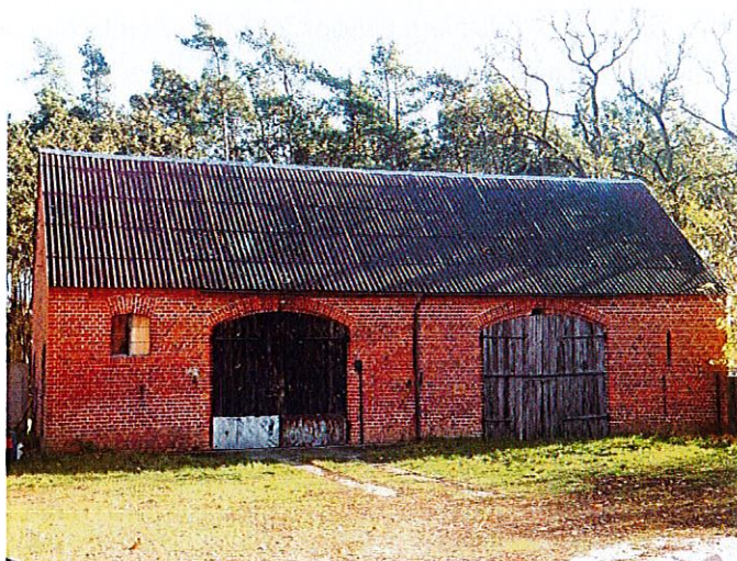
Fot. 16. Budynek gospodarczy nr 1 w zespole kościoła w Cielu
