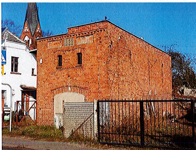
Fot. 11. Budynek gospodarczy przy poczcie w Łochowie
