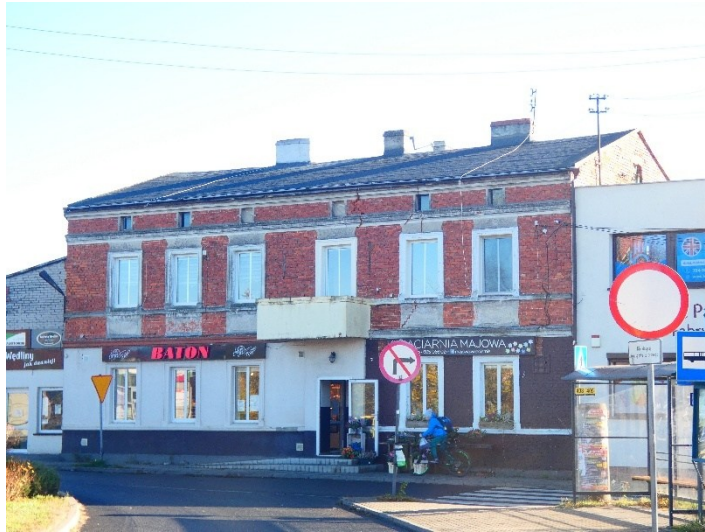
Fot. 10. Dom, ob. budynek mieszkalno-usługowy w Łochowie
