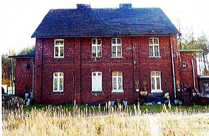
Fot. 13. Dworzec w Jasieńcu Stacji, ob. budynek mieszkalny
