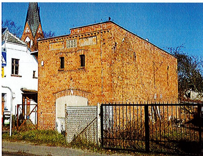
Fot. 11. Budynek gospodarczy przy poczcie w Łochowie
