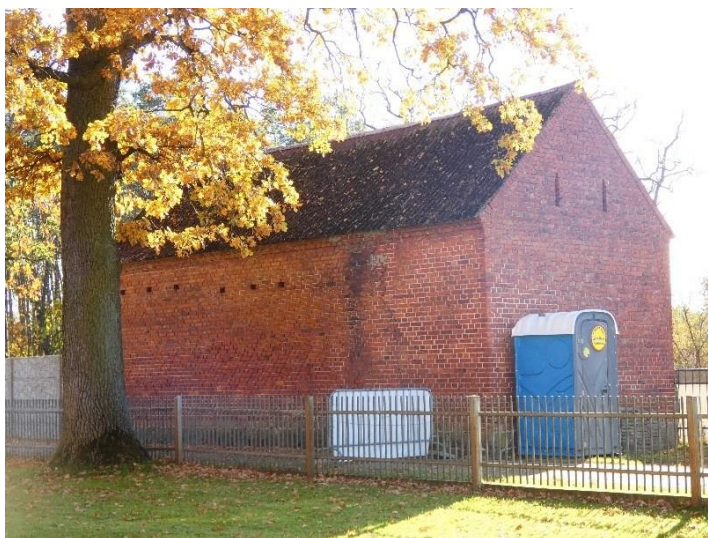
Fot. 17. Budynek gospodarczy nr 2 w zespole kościoła w Cielu
