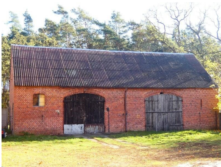
Fot. 16. Budynek gospodarczy nr 1 w zespole kościoła w Cielu
