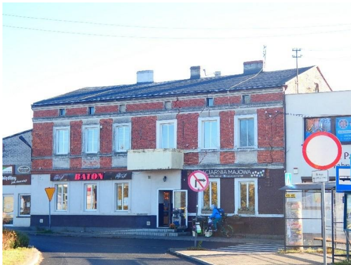
Fot. 10. Dom, ob. budynek mieszkalno-usługowy w Łochowie
