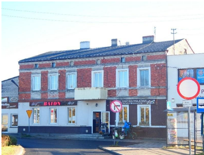
Fot. 10. Dom, ob. budynek mieszkalno-usługowy w Łochowie
